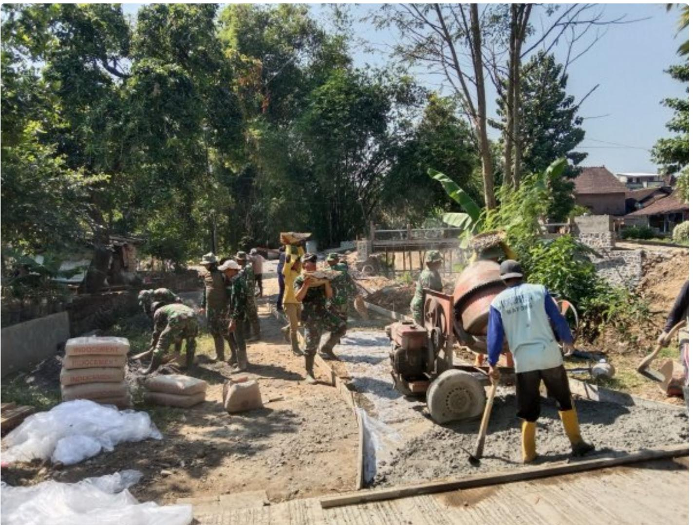
KUDUS - Pada kegiatan TNI Manunggal Membangun Desa (TMMMD) Sengkuyung Kodim 0722/Kudus, salah satu proyek yang menjadi fokus adalah pembuatan jembatan di Desa Kaliwungu. Proses pembangunan jembatan ini telah memasuki tahap pengecoran, yang merupakan langkah penting dalam penyelesaian struktur jembatan tersebut, Kamis (8/8/2024).
